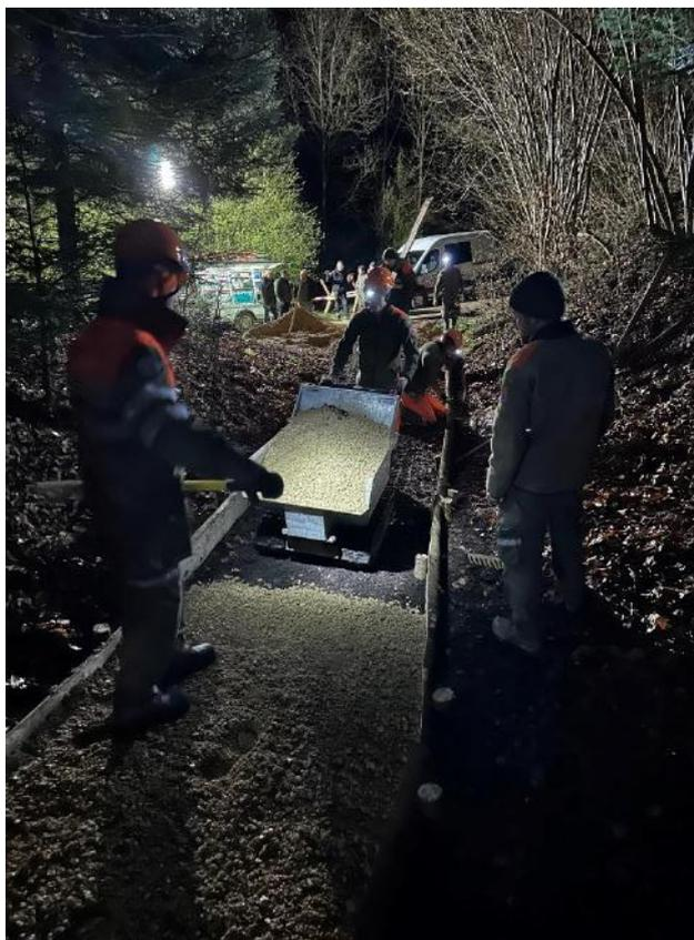
Nach Einsetzen der Wegränder mit Holzstangen wurde die Mergelschicht, - wie bei den vorangehenden Wegaufbereitungen auf der Hasenburg, - mit einem Raupendumper eingelegt und darauf mit einer sog. Rüttelplatte verdichtet.
