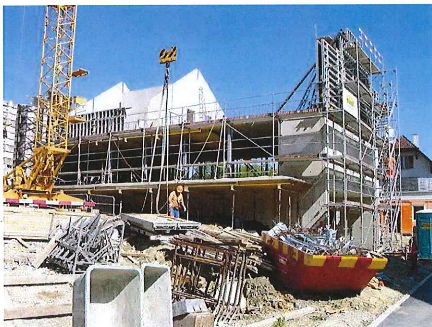
Neubau Mehrzweckgebäude, Stand 14 Mai 2012
